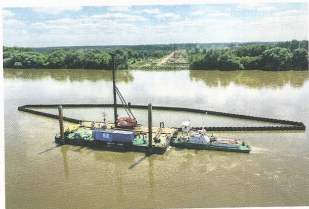
Rys. 2. „Domykanie” obudowy wyspy; widoczne: obudowa stalowa wyspy, platforma pływająca z podporami szczudłowymi, holownik oraz kufar z wibratorem
