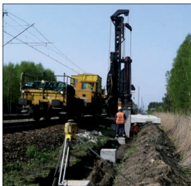
Fot. 5 | Wbijanie pali ekranowych z toru
