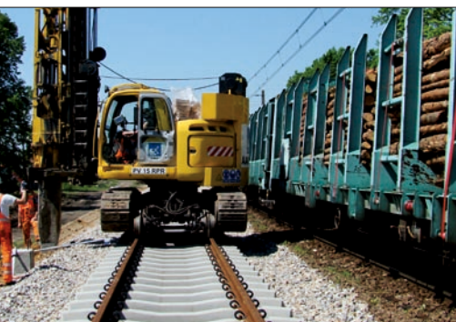
Fot. 1 | Pogrążanie pali trakcyjnych z toru
