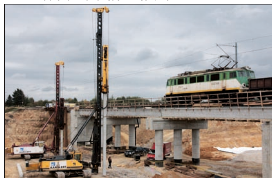
Fot. 3 | Prefabrykowane fundamenty palowe wiaduktu kolejowego WK1 nad S19 w okolicach Rzeszowa
