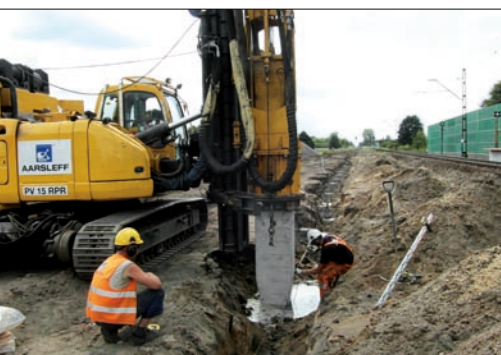
Fot. 2 | Pogrążanie pali trakcyjnych z terenu przyległego
