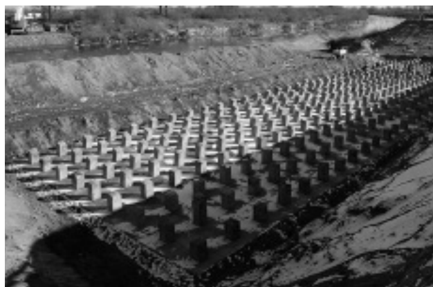
Fot. 1. Fundament pałowy mostu autostradowego przez San w ciągu A4 [1]
