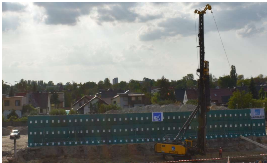
Rys.8. Przenośny ekran akustyczny, inwestycja w Opolu, w tle widoczna zabudowa jednorodzinna oraz korona wału ziemnego
