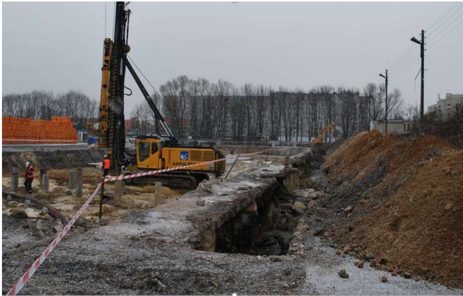
Rys.10. Przekop ograniczający przenoszenie wibracji, inwestycja w Opolu
