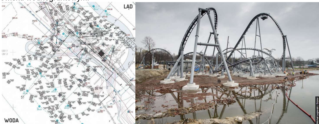
Rys. 17 i 18. Legendia, plan budowy oraz konstrukcja w trakcie wznoszenia [3]
