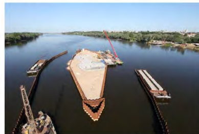
Budowa zabezpieczenia wyspy ....
