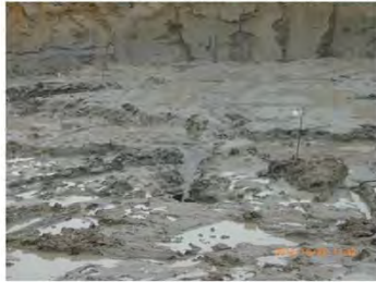
Bezpośrednio po wykonaniu wykopu
