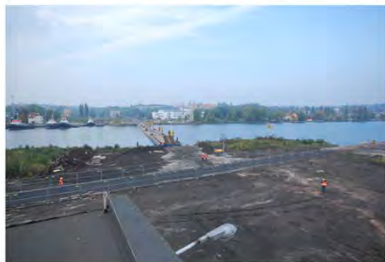
Budowa mostu pontonowego na wyspę
