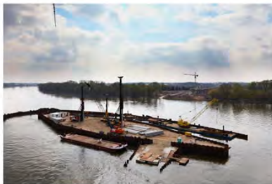
Wykonanie fundamentu palowego podpory środkowej łuków
