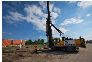
Badania nośności pali
