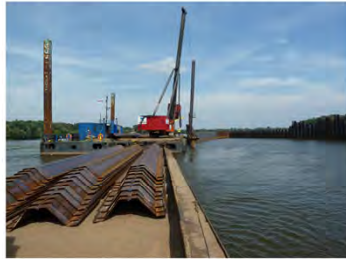
Roboty kafarowe z platformy pływającej
