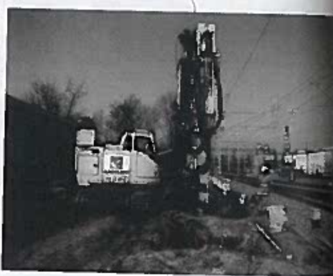
Rys. 14. Wbijanie pali prefabrykowanych pod fundamenty ekranów akustycznych przy użyciu kafara torowego poruszającego się na gąsienicach (archiwum Aarsleff sp. z o.o.)
