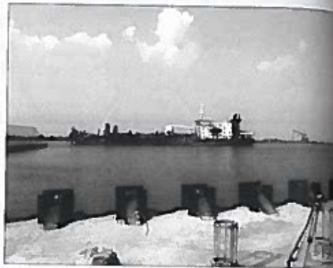
Rys. 42. Profile stalowe – terminal kontenerowy w Porcie Północnym w Gdańsku (T. Brzozowski)
