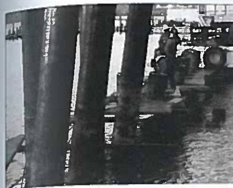
Rys. 33. Budowa mariny przy moło w Sopocie – łączenie pali stalowych
