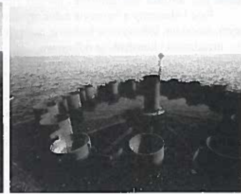
Rys. 48. Konstrukcja fundamentu stawy nawigacyjnej
