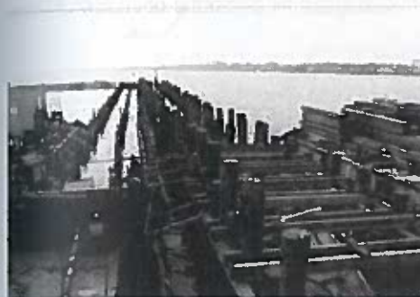
Rys. 29. Budowa mariny przy molo w Sopocie – widok na pale drewniane
