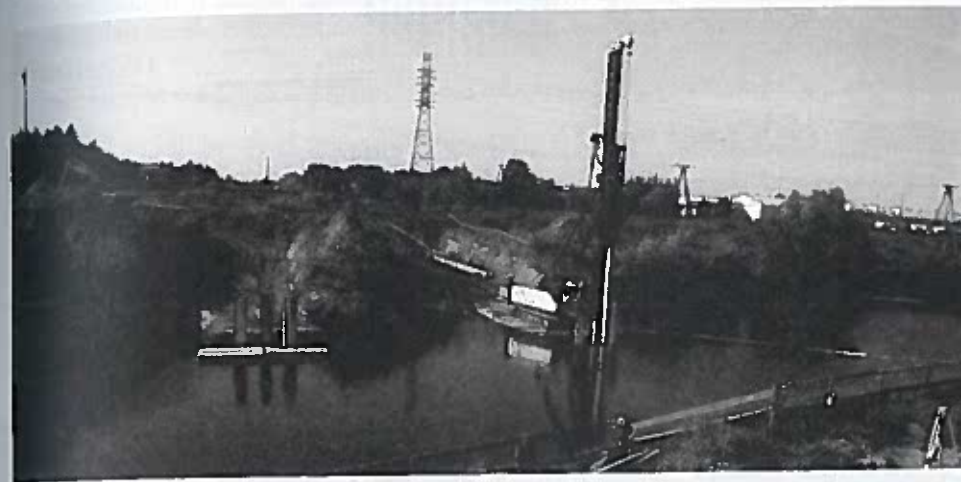
Rys. 15. Pałowanie fundamentów podpór tymczasowych w korycie Wisłoka [9] z tymczasowej grobli przy użyciu kafara z młotem hydraulicznym
