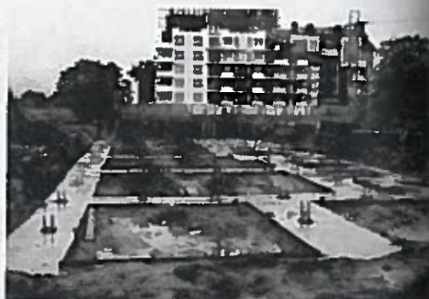
Rys. 20. Fundament budynku mieszkalnego wielorodzinnego w Kołobrzegu
