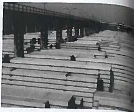
Rys. 12. Magazyn prefabrykatów pali
