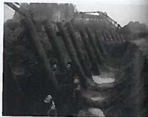
Rys. 44. Palisada zabezpieczająca – A2 (Transprojekt Gdański)
