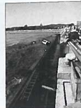
Rys. 34. Budowa mariny przy moło w Sopocie – ścianka szczelna
