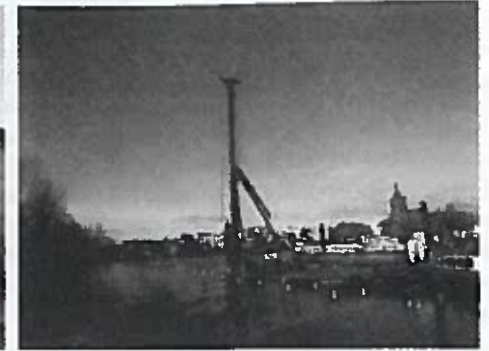
Rys. 46. Wbijanie rur stalowych pod pomost spacerowy na jeziorze Chelmskim przy użyciu kafara na platformie pływającej
