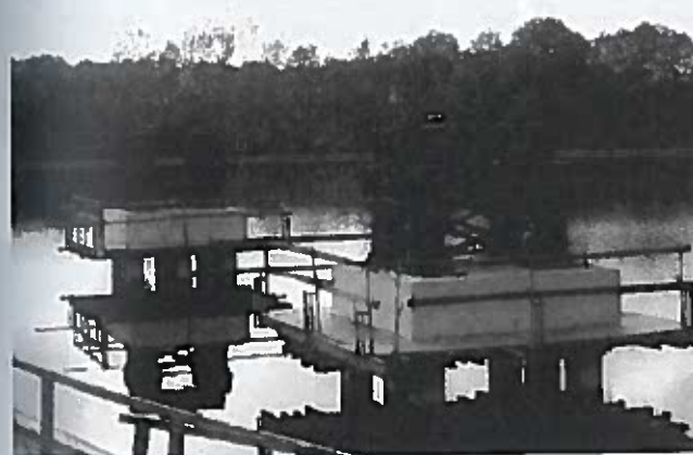
Rys. 16. Podpory tymczasowe w zbiorniku Elektrociepłowni Rzeszów [9]
