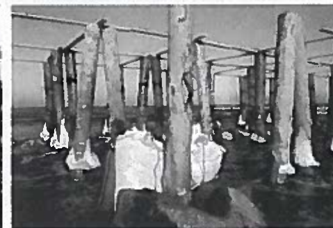
Rys. 30. Badanie dynamiczne pali drewnianych w Ustroniu Morskim
