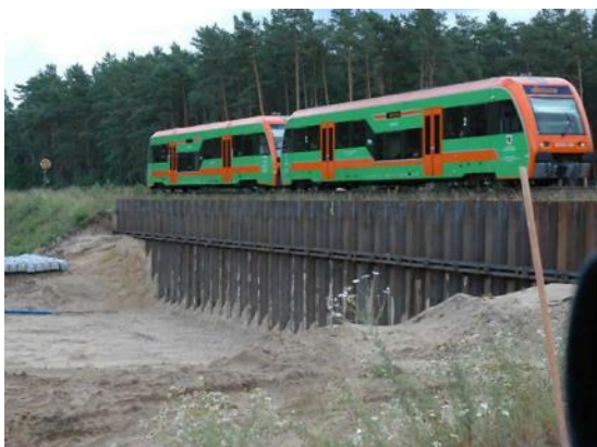
Rys. 6. Zabezpieczenia tymczasowe torowiska ściankami szczelnymi wciskanymi ze ściągami – obiekt WA 81/A1 (archiwum Aarsleff sp. z o.o.)
