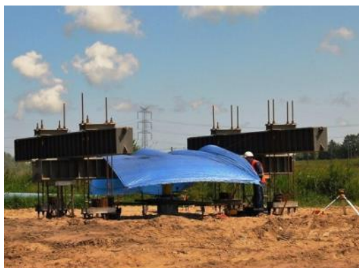
Fot. 5. Statyczne badanie nośności metodą belki odwróconej (arch. Aarsleff sp. z o.o.)
