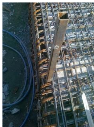
Fot. 8. Rurka inklinometryczna wbudowana w przyczółek mostowy z grodzic stalowych (arch. Aarsleff sp. z o.o.)
