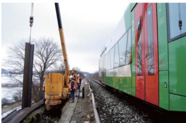
Rys. 5. Wykorzystanie ścianki stalowej wciskanej do zwiększenia stateczności i nośności nasypu kolejowego w Niemczech (archiwum Giken)
