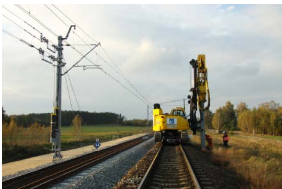
Fot. 1. Pał prefabrykowany w trakcie wbijania kafarem torowym z nieprzebudowanego toru
