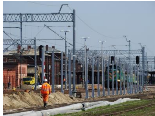
Fot. 4. Słupki ekranów akustycznych posadwione na żelbetowych palach prefabrykowanych na terenie stacji Brzeg (archiwum Aarsleff sp. z o.o.)
