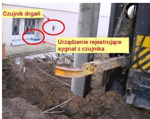
Fot. 7. Pomiary drgań (arch. Aarsleff sp. z o.o.)
