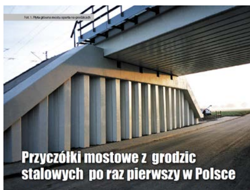
Fot. 14. Ilustracja artykułu reklamowego jednego z głównych dostawców grodzic – wiadukt kolejowy ( www.geoinzynieria.com )
