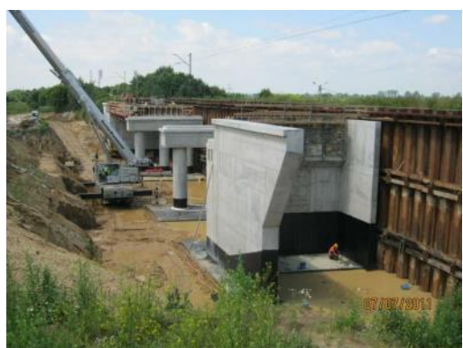
Fot. 13. Wiadukt w trakcie budowy pierwszej połówki (archiwum Promost Consulting Rzeszów)
