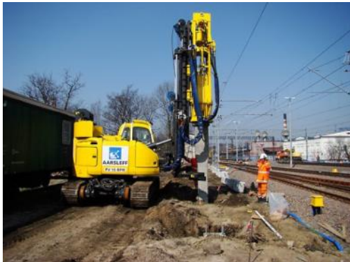
Fot. 3. Wbijanie pali prefabrykowanych pod fundamenty ekranów akustycznych przy użyciu kafara torowego poruszającego się na gąsienicach (archiwum Aarsleff sp. z o.o.)
