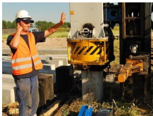
Fot. 6. Dynamiczne badanie nośności pała przy dużych odkształceniach (arch. Aarsleff sp. z o.o.)
