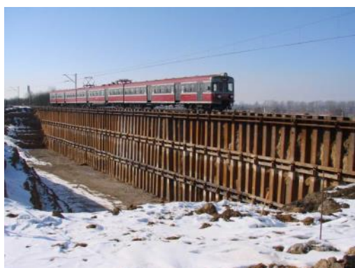
Fot. 9. Zabezpieczenie użytkowanego torowiska w trakcie budowy wiaduktu kolejowego nad drogą ekspresową (archiwum Pomost Consulting Rzeszów)
