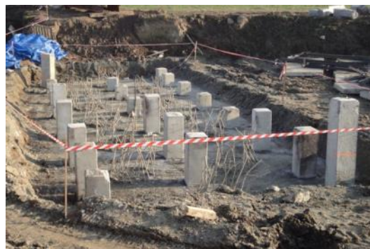
Fot. 5. Wzmocnienie palami wbijanymi nowego fundamentu z pali wierconych o niewystarczającej nośności (archiwum Aarsleff sp. z o.o.)
