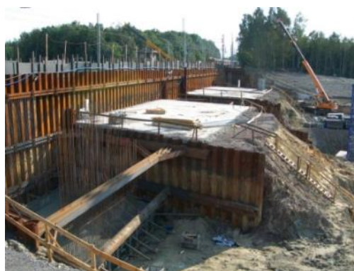
Fot. 10. Zabezpieczenie torowiska i wykopów pod podpory wiaduktu ( www.geoinzynieria.com )
