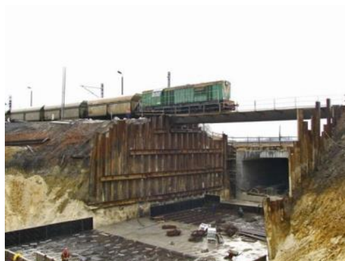
Fot. 12. Zabezpieczenie wykopu w Bytomiu [21]
