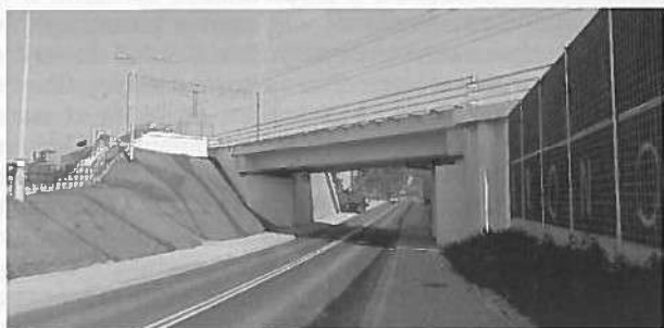
Rys. 4. Wiadukt nad ulicą Balicką
