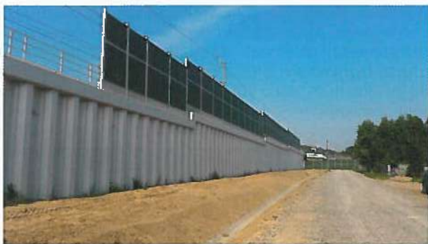
Rys. 8. Wykonany nasyp kolejowy w obudowie z grodzic stalowych
