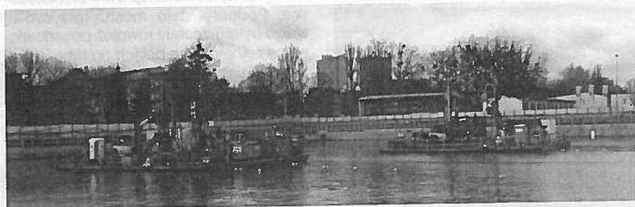
Rys. 9. Wykonywanie mikropali samowiercących z platform pływających [6]
