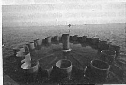
Rys. 14. Montaż ściągów tymczasowych [1]
