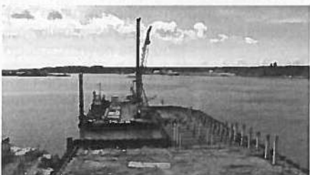
Rys. 4. Budowa nabrzeża w porcie w Świnoujściu [6] – palowanie przy użyciu kafara z platformy pływającej typu jack-up
