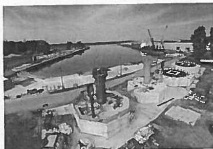
Rys. 15. Betonowanie elementów prefabrykowanych zwieńczeń staw [1]
