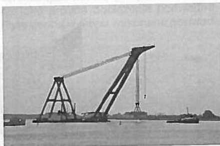
Rys. 16. Transport i montaż prefabrykatów – część dolna o masie 540 t [1]
