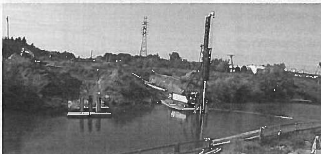
Rys. 6. Palowanie fundamentów podpór tymczasowych w korycie Wisłoka [3] z tymczasowej grobli przy użyciu kafara z młotem hydraulicznym
