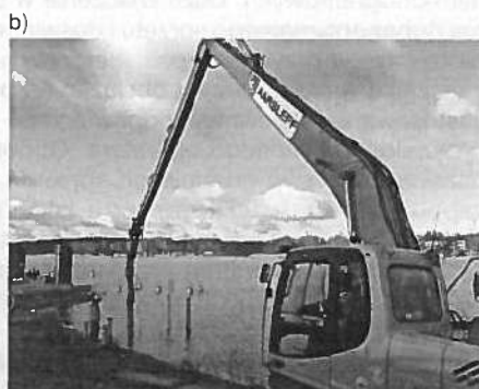
Rys. 1. Wbijanie pali drewnianych pod pomosty rekreacyjne na jeziorze Krzywe w Olsztynie przy użyciu kafara na platformie pływającej (po lewej) i z łądu przy użyciu młota na ramieniu koparki (po prawej) [6]
