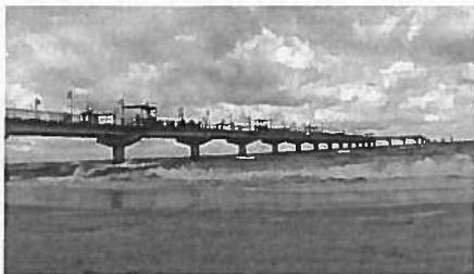
Rys. 3. Molo w Międzyzdrojach na monopalach rurowych [6]; monopale wibrowane przy użyciu dźwigu z platformy pływającej stabilizowanej na dnie morza
