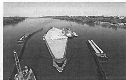
Rys. 11. Wibrowanie grodzic przy użyciu kafara na platformie pływającej oraz wyspa po zakończeniu robót palowych [2]
