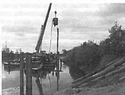
Rys. 2. Wibrowanie dalb na Wiśle koło Polanica [6] z platformy pływającej i wibratora zawieszzonego na ramieniu dźwigu
