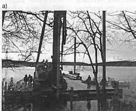
Rys. 1. Wbijanie pali drewnianych pod pomosty rekreacyjne na jeziorze Krzywe w Olsztynie przy użyciu kafara na platformie pływającej (po lewej) i z łądu przy użyciu młota na ramieniu koparki (po prawej) [6]
