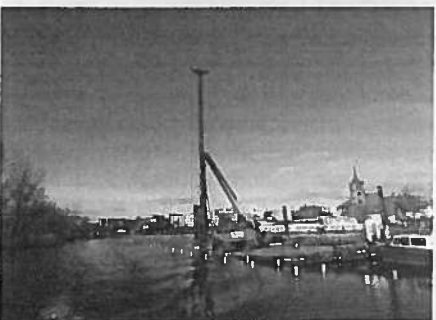
Rys. 5. Wbijanie rur stalowych pod pomost spacerowy na jeziorze Chełmżyńskim [6] przy użyciu kafara na platformie pływającej
