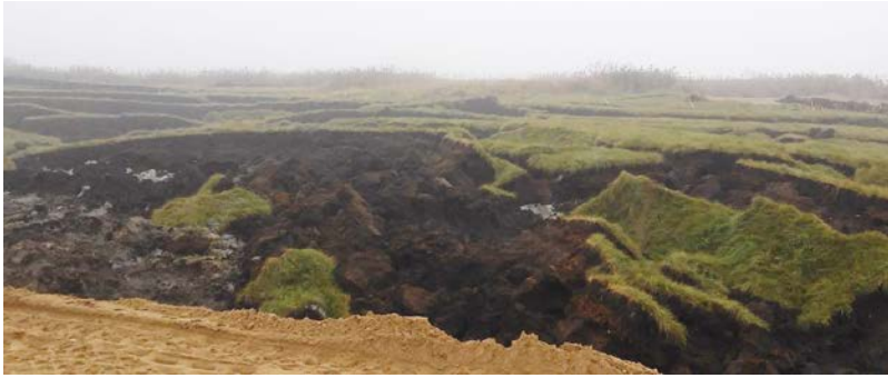
Fot. 1. Torfowisko bezpośrednio przed rozpoczęciem budowy platformy
