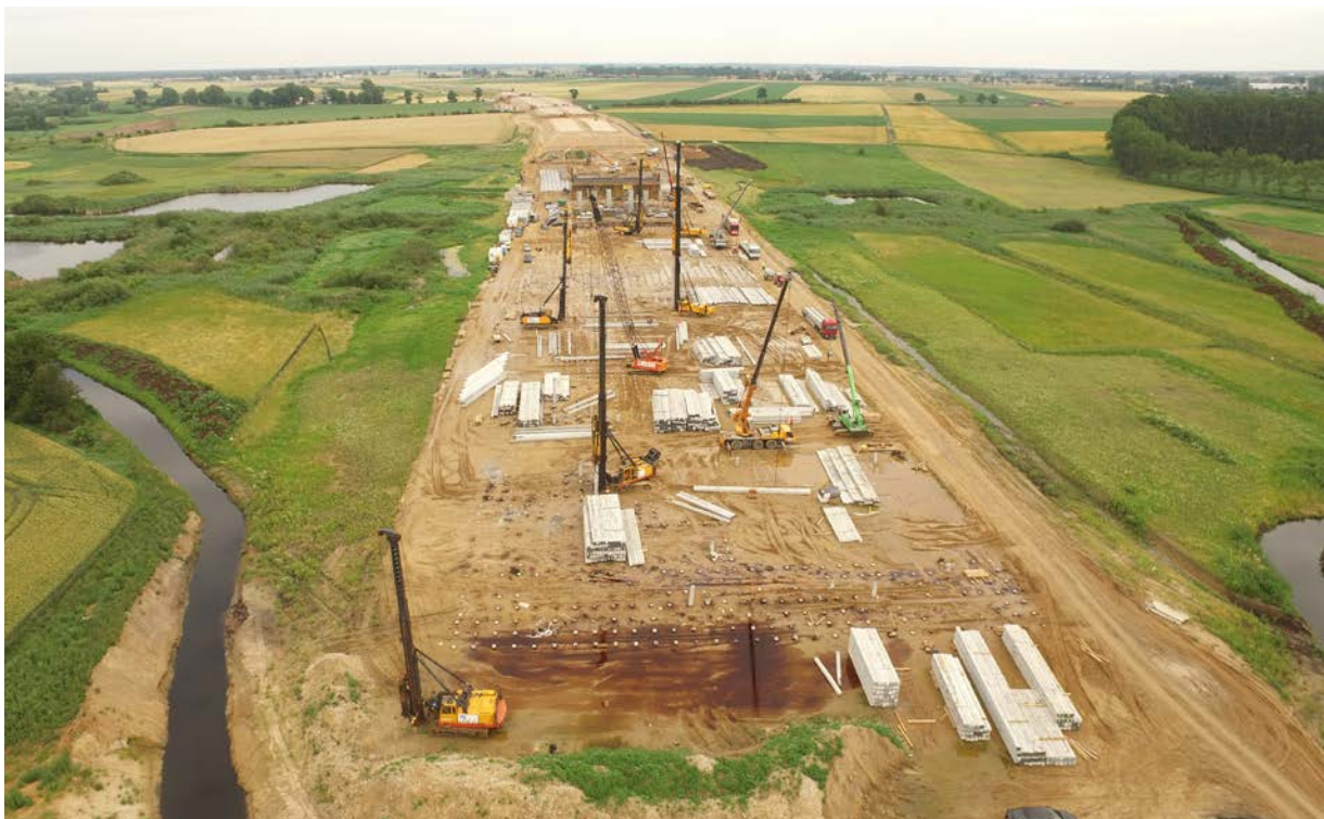
Fot. 7. Palowanie od strony Poznania
