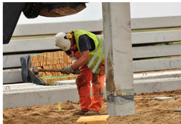
Fot. 5. Łączenie pali
