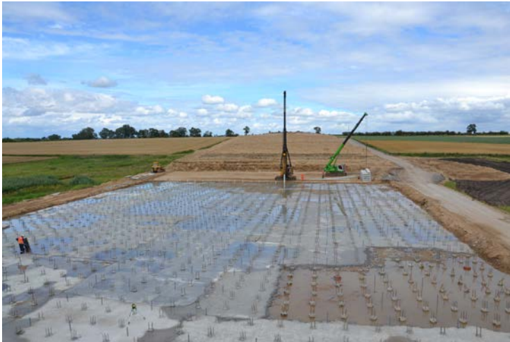
Fot. 8. Zakończenie robót palowych – roboty wykończeniowe
