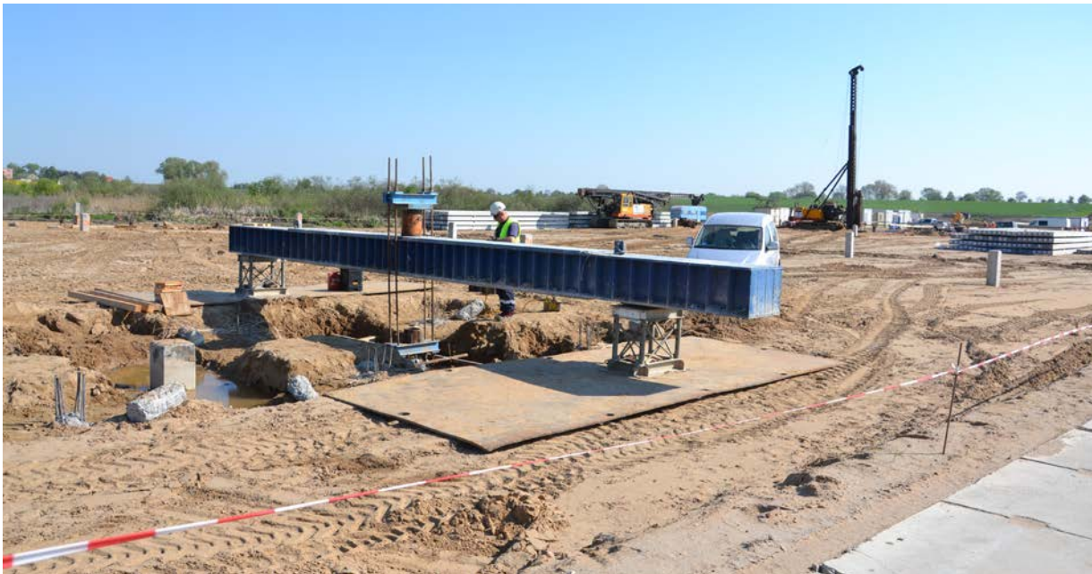
Fot. 3. Badania nośności pali – próbne obciążenie statyczne na wyciąganie
