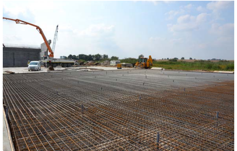
Fot. 9. Zbrojenie płyty zwieńczającej pale
