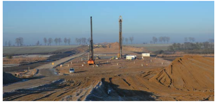
Fot. 2. Rozpoczęcie robót palowych – wbijanie pali testowych/świadków
