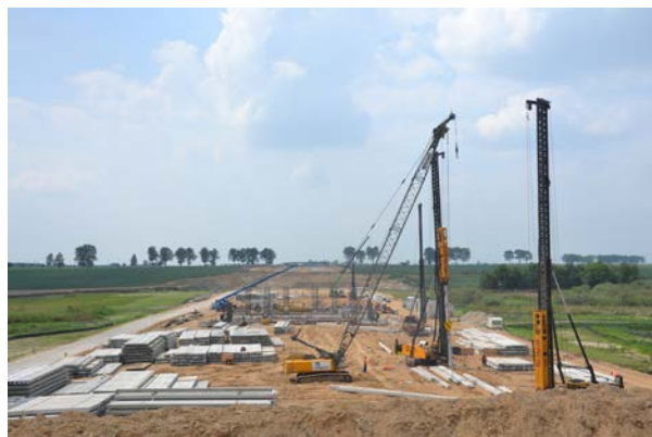
Fot. 4. Palowanie zasadnicze i tworzenie magazynu pali na placu budowy
