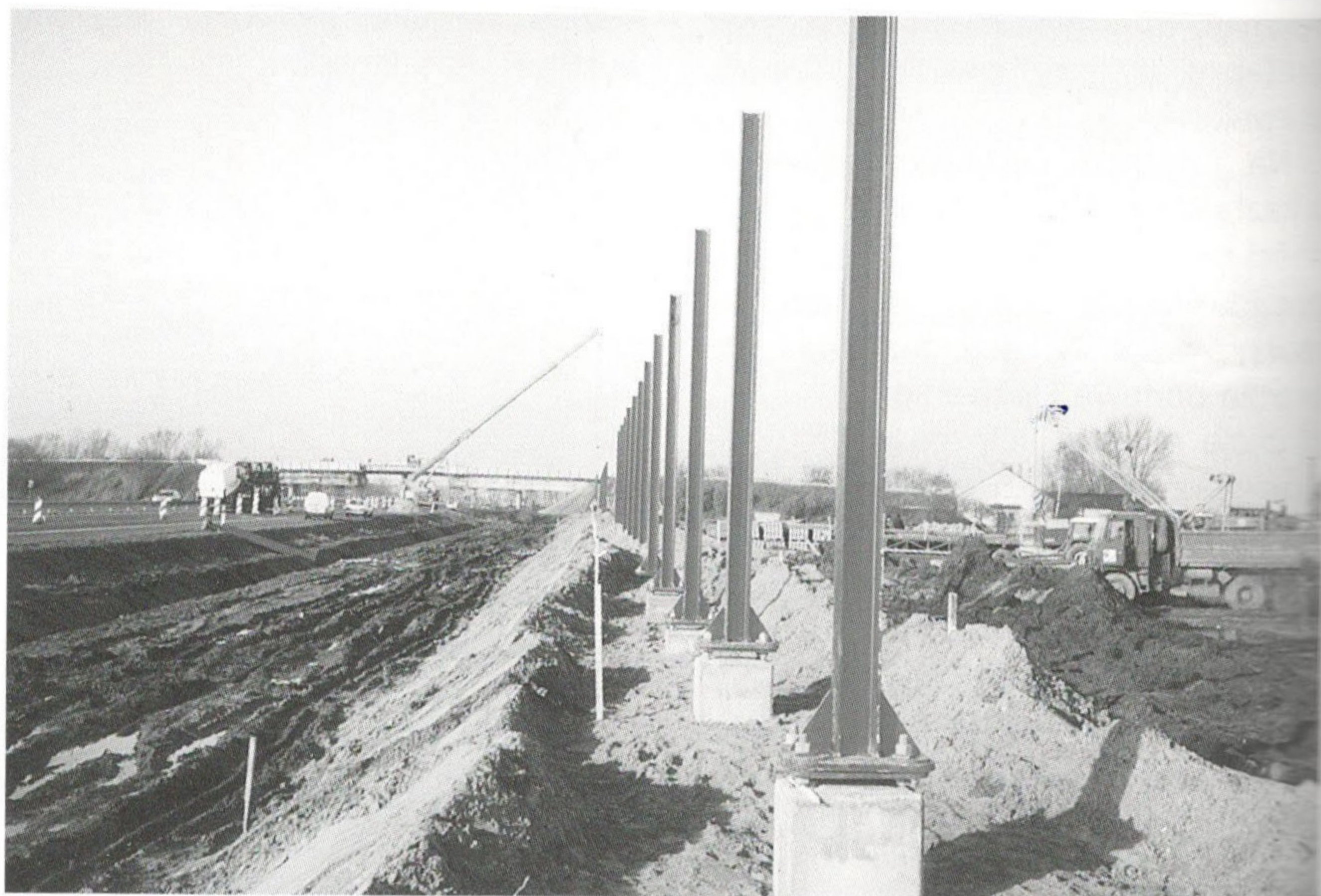
Fot. 2. Pale pod konstrukcje wsporcze ekranu akustycznego przy autostradzie A-2 na odcinku Września – Konin
