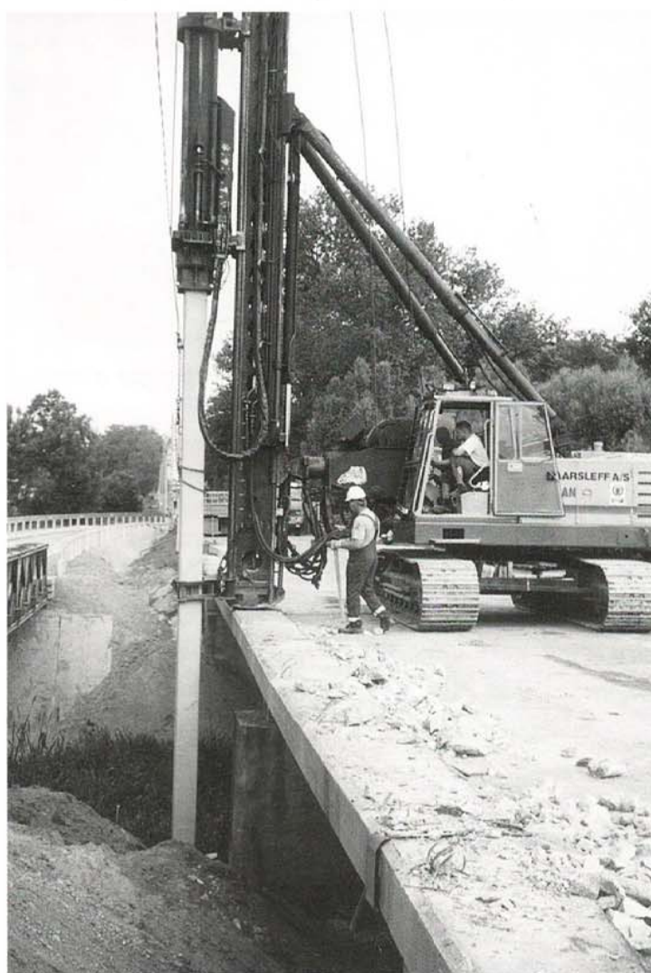
Fot. 1. Wbijanie pali pod podpory mostu w Czyżewie kafarem firmy „Aarsleff” Sp. z o.o.
