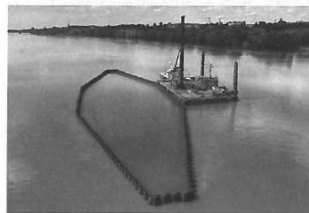
Rysunek 22. „Domykanie” obudowy wyspy – wibrowanie grodzic przy użyciu kafara na platformie pływającej
