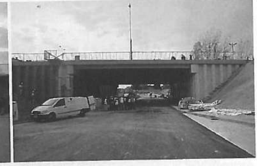
Rysunek 12. Wiadukt zintegrowany w ciągu al. Krakowskiej w Rzeszowie z grodzicami bez okładziny
