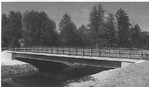
Rysunek 13. Zintegrowany most drogowy w Bałtowie posadowiony na prefabrykowanych palach stalowych z kształtowników HEB
