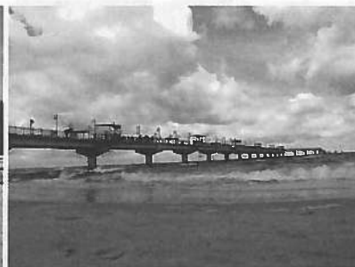
Rysunek 14. Molo w Międzyzdrojach na monopalach rurowych – monopale wibrowane przy użyciu dźwigu z platformy pływającej stabilizowanej na dnie morza
