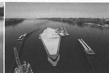
Rysunek 23. Wyspa po zakończeniu robót palowych
