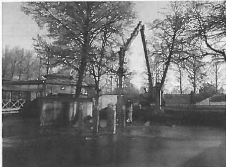
Rysunek 7. Wbijanie pali drewnianych pod trwałe pomosty rekreacyjne dla pieszych
