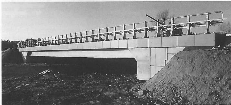
Rysunek 9. Zespólny most zintegrowany posadowiony na palach stalowych fundamentowych typu H, Wólka Niedźwiecka, woj. Podkarpackie
