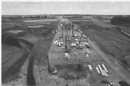
Rysunek 24. Palowanie pod nasyp drogi ekspresowej S5 koło Gniezna
