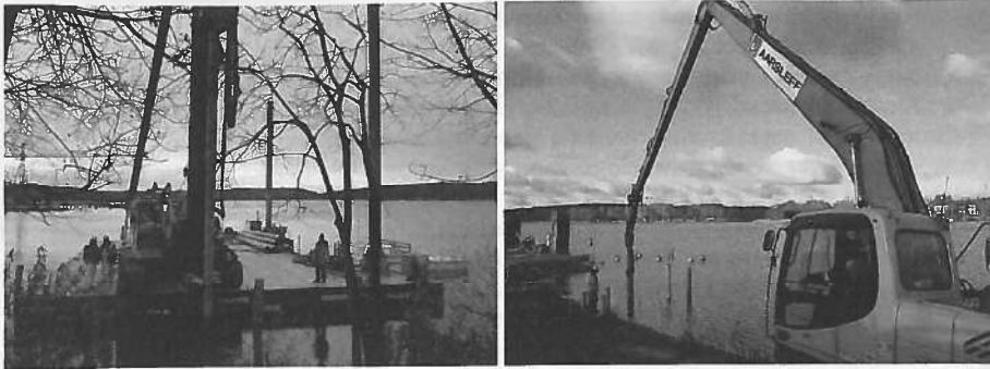
Rysunek 6. Wbijanie pali drewnianych pod pomosty rekreacyjne na jeziorze Krzywe w Olsztynie z wody przy użyciu kufara na platformie pływającej (po lewej) i z łądy przy użyciu młota na ramieniu koparki (po prawej)
