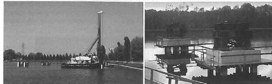
Rysunek 18. Wbijanie pali w fundamentach podpór tymczasowych w zbiorniku elektrociepłowni Rzeszów; gotowe podpory tymczasowe w zbiorniku Elektrociepłowni Rzeszów [5]
