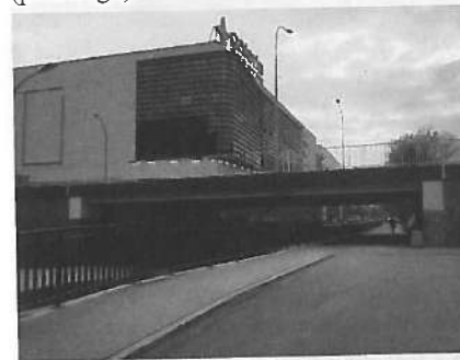
Rysunek 11. Miejski wiadukt zintegrowany budowany metodą „top&down” posadowiony na grodzicach stalowych, Rzeszów
