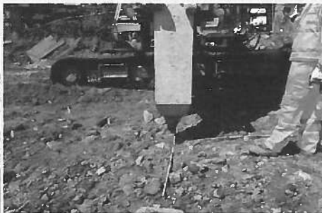
Rysunek 25. Żelbetowy pal prefabrykowany z końcówką skalną wbijany w fundamentach obiektu mostowego w Suchej Beskidzkiej
