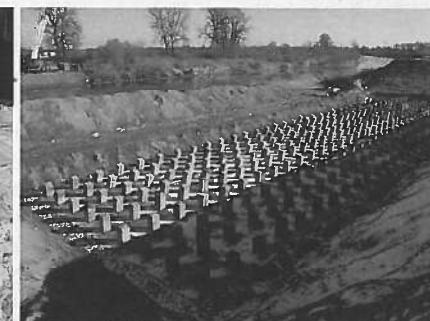
Rysunek 16. Fundament palowy mostu autostradowego przez San w ciągu A-4
