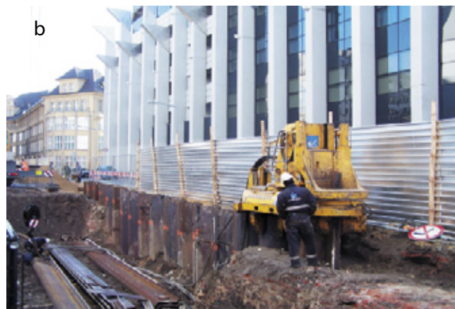
Fot. 1. Jedna z ostatnich realizacji firmy Aarsleff Sp. z o.o. – wciskanie ściany z grodzic stalowych firmy Arcelor: a) rama startowa z balastem, b) ścianka wciskana wzdłuż ulicy w zwartej zabudowie miejskiej Wrocławia (marzec 2006)
