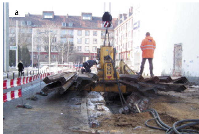
Fot. 1. Jedna z ostatnich realizacji firmy Aarsleff Sp. z o.o. – wciskanie ściany z grodzic stalowych firmy Arcelor: a) rama startowa z balastem, b) ścianka wciskana wzdłuż ulicy w zwartej zabudowie miejskiej Wrocławia (marzec 2006)
